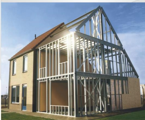
Estruturas light steel frame misturam aço e concreto
